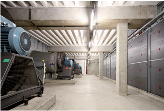
Zuluftzentrale für 800 000 m 3 /h Zuluftvolumenstrom. Vier bestehende Ventilatoren mit Flügelverstellung führen dem Gebäude die nötige Aussenluft zu.
