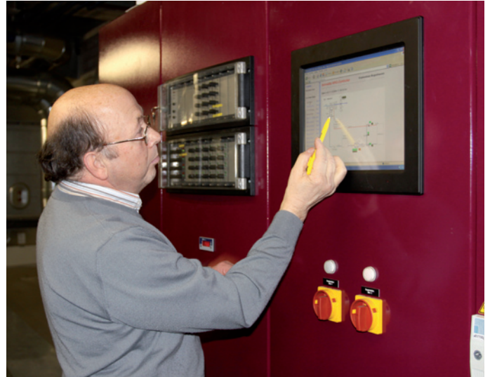
Alle Daten des WRG-Controllers können über einen Touchscreen abgerufen werden. Im Bild Albert Holzbauer, langjähriger Betreuer der WRG.
