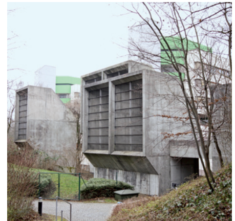
Zentrale Aussenluftfassung zur Versorgung der raumlufttechnischen Anlagen des Klinikums. (Bilder: Konvekta AG)
