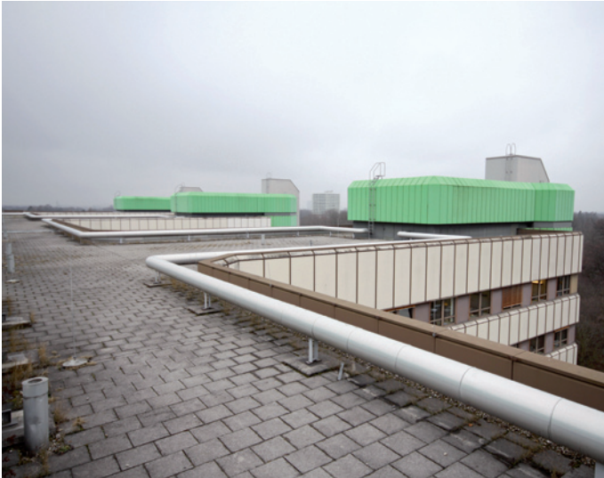
Das aus dem Jahr 1979 stammende Rohrsystem (nach Tichelmann) verbindet zehn Abluftzentralen auf dem Dach mit der Zuluftzentrale im 2. UG.
