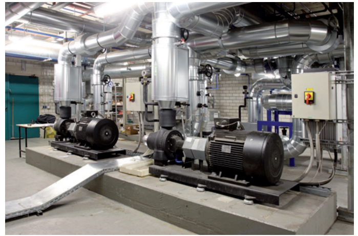
Statt acht Pumpen sorgen heute zwei FU-geregelte Umwälzpumpen für einen energie- und leistungsoptimierten Durchfluss.
