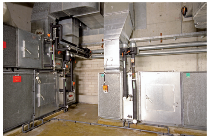
Im Zuge der KVS-Modernisierung wurden sowohl die WRG-Luftkühler als auch die Anschlussgruppen mit Regel- und Absperrventilen komplett erneuert.
