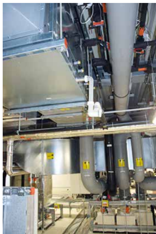
Die zentrale Wärme- bzw. Energierückgewinnung durch das Kreislaufverbundsystem (KVS) von Konvekta sorgt für höchste Effizienz und spart gehörige Mengen an Wärme, Kälte und Strom ein.
