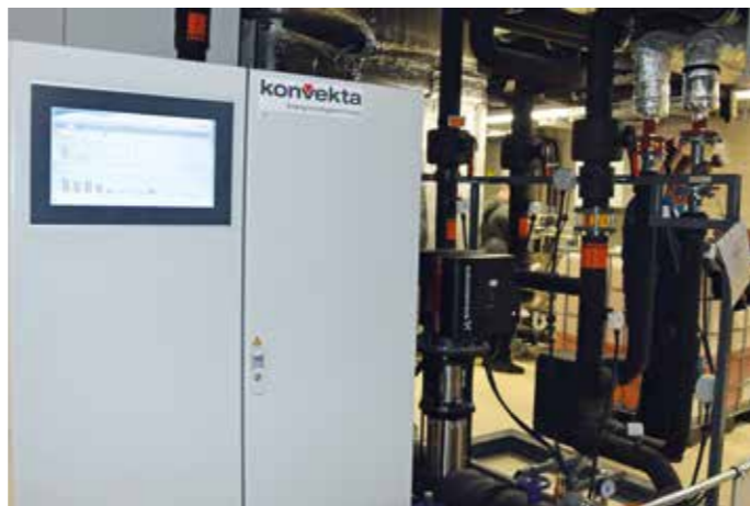
Die zentrale Wärme- bzw. Energierückgewinnung durch das Kreislaufverbundsystem (KVS) von Konvekta sorgt für höchste Effizienz und spart gehörige Mengen an Wärme, Kälte und Strom ein.
